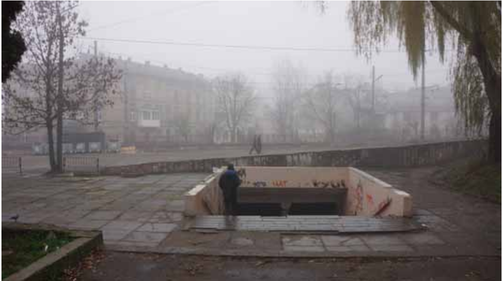
Фото 8: Підземний перехід через залізницю на вул. Б.Хмельницького Джерело: Андрій Бондаренко
